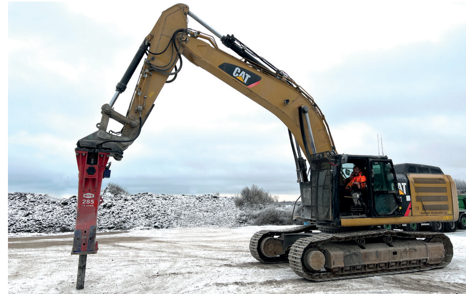
Cat 336E -kaivukone varustettuna MTB 285 -iskuvasaralla on tehokas paketti kiven rikutukseen.
