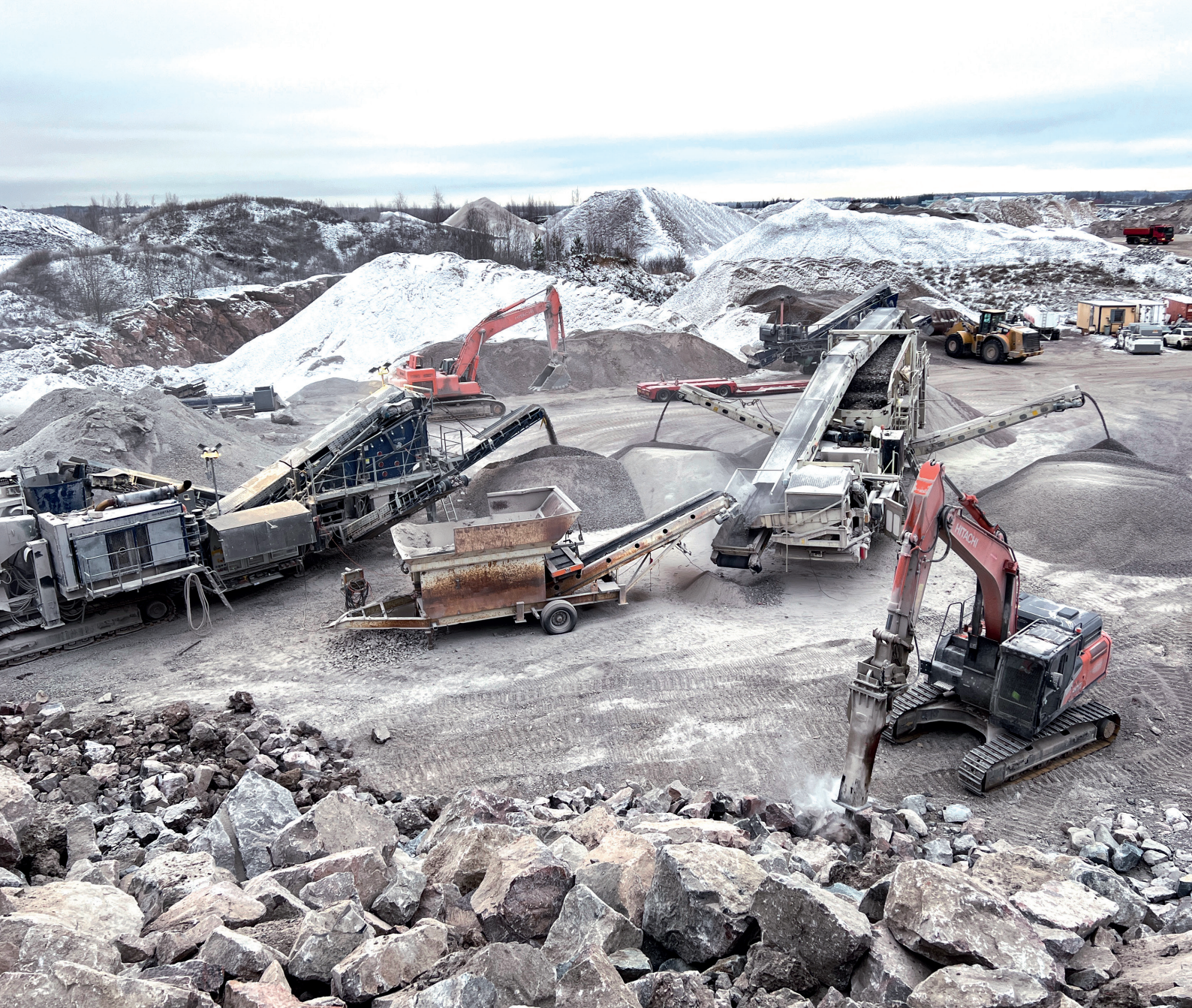
Suomen Maansiirto Oy keskittyy louhintapalveluun ja irrotetun kiven vasarointiin. Kuvassa ollaan ASM Kiviainespalvelun Vantaan toimipisteessä Hitachi Zaxis 300LC -kaivukoneella, missä vasarana MTB 285.
